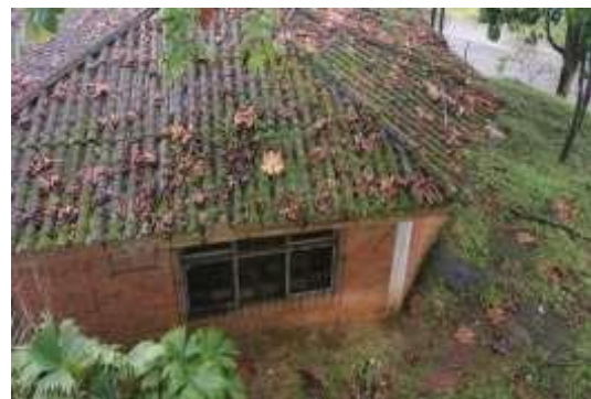
Figura 2 Cubierta en mal estado.
