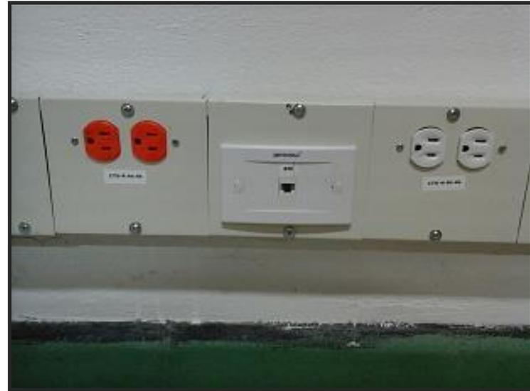
Cada instalación contiene: Puntos de red, Eléctricos Regulados y No Regulados
