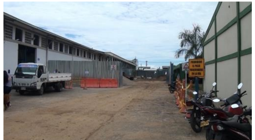
CAMPUS CENTRO CONSTRUCCIÓN EDIFICIO DE 7 PISOS
